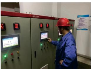
城市御园小区生活水泵房二次加压设备安装时间已久，设备上精密电气元件像变频器、恒压控制器、压力传感器等在长时间运作下已达到使用寿命年限，急需更换才能继续供水。
