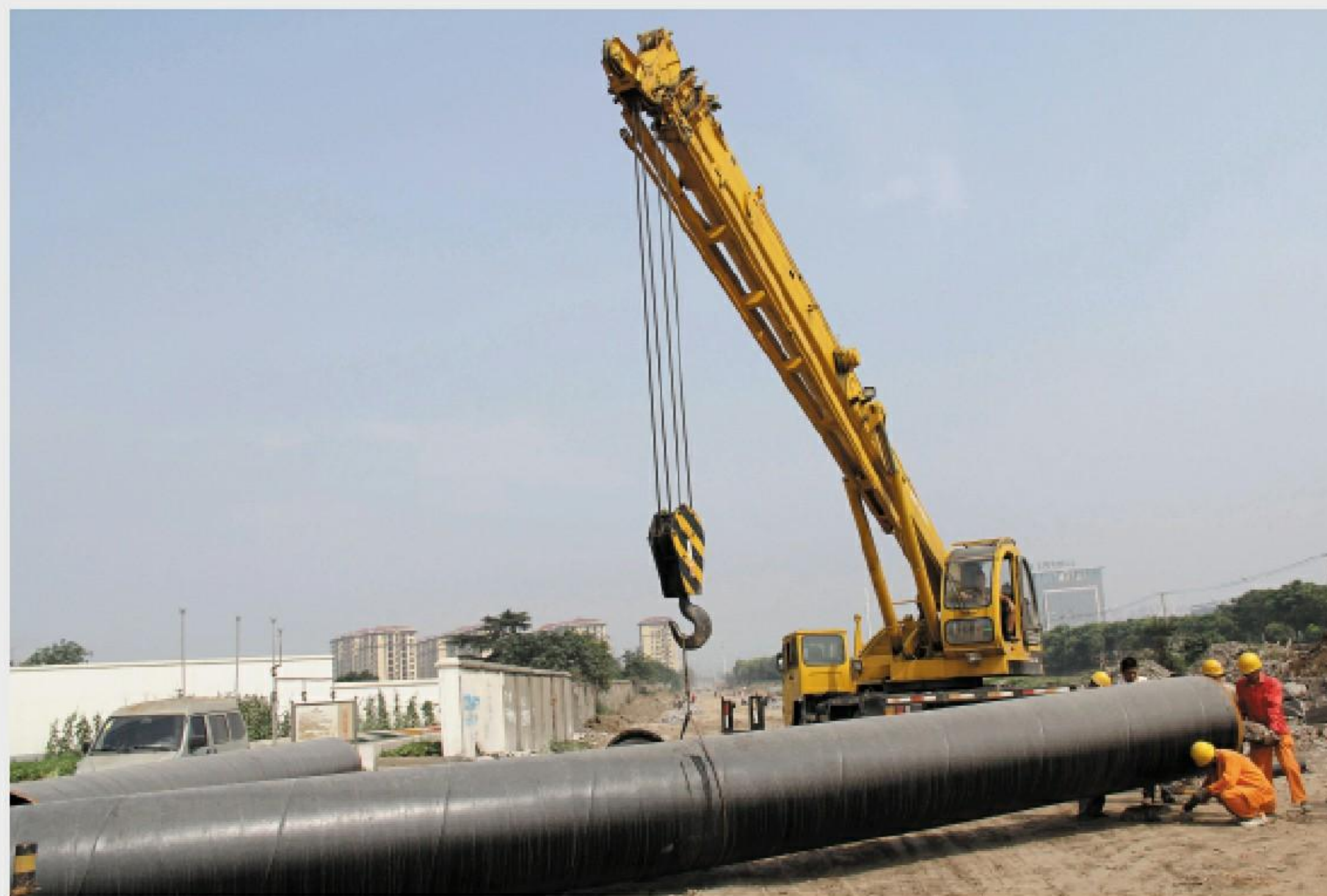
6月,集团公司耗资三百余万元将三湾路地段的DN1000mm的水泥管更换为DN1000mm的球墨铸铁管,提高了城市供水安全。
